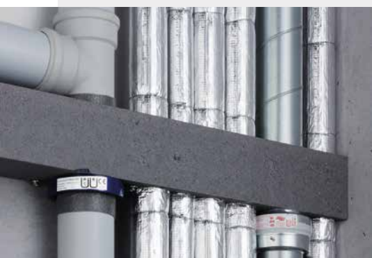
Die steinwool Isolierschale Alu von Steinbacher gewährleistet erstklassige Dämmung sowie sicheren Brandschutz.
