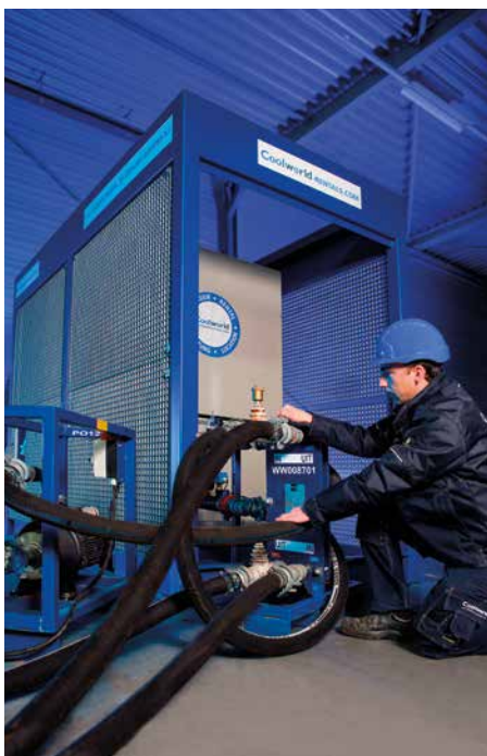
Temporäre Chiller zum Kühlen oder Erwärmen von Prozesswasser.
