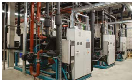
Die drei R1234yf Kältemaschinen/Wärmepumpen fertig installiert im Maschinenraum.
