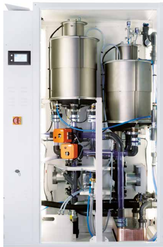
Der eChiller – Kaltwassersatz, der mit reinem Wasser als Kältemittel (R718) arbeitet und markt-/lieferfähig ist.
